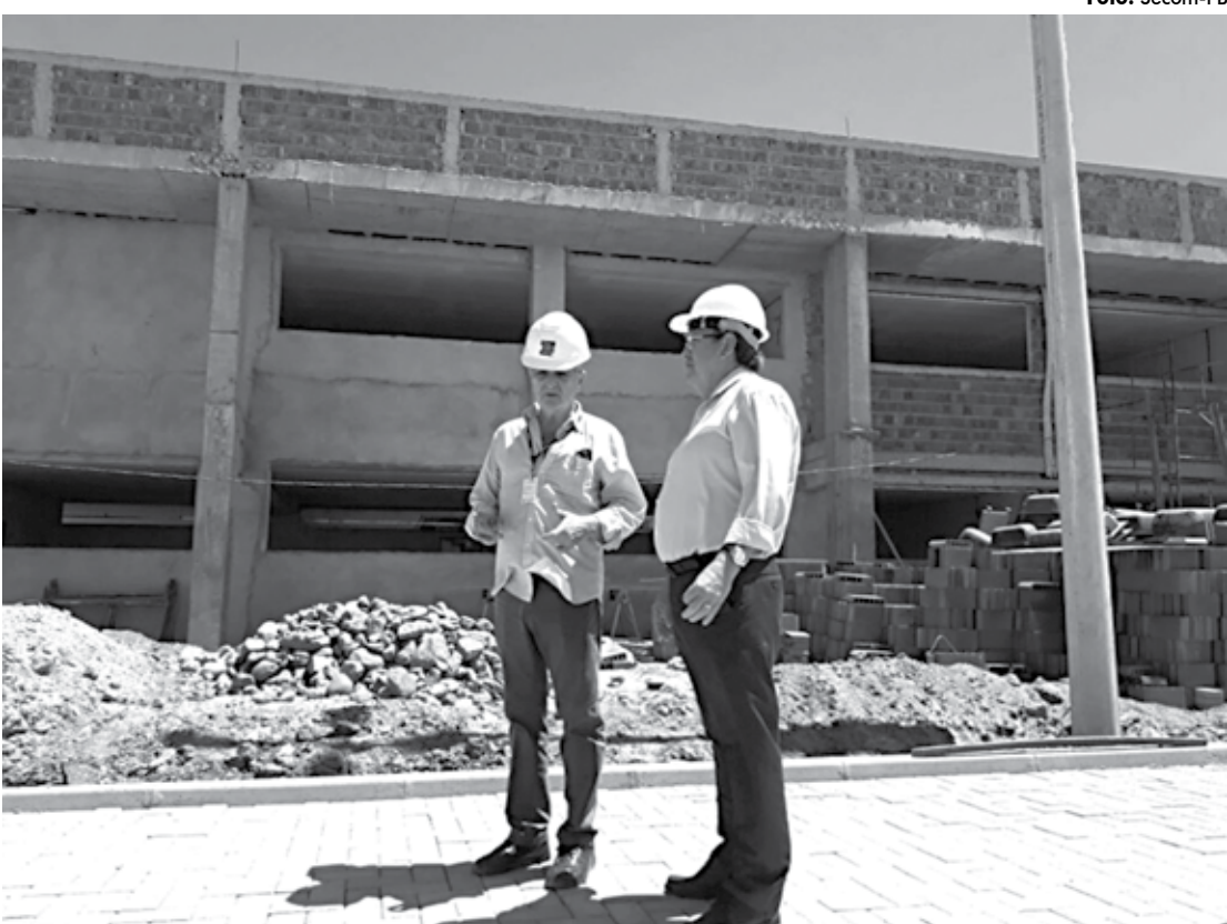
Secretário de Infraestrutura, João Azevêdo, visita obras de construção da Escola Técnica Integral de Campina Grande
